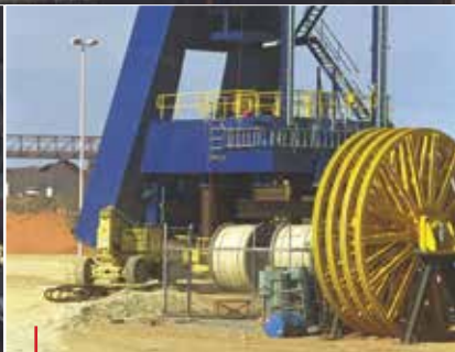
Wstępny montaż kół linowych i podestów kół linowych
