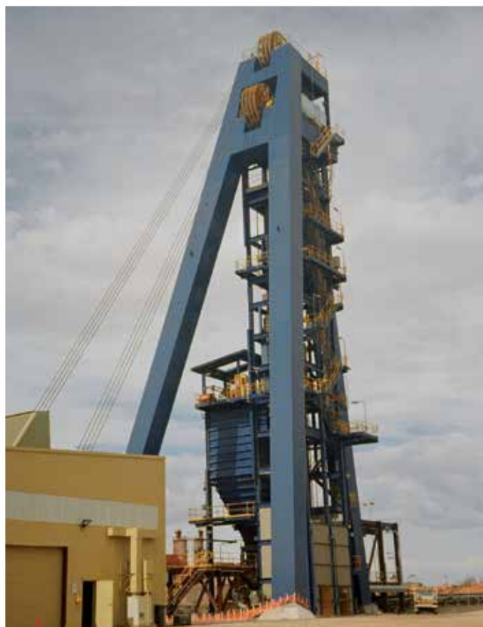
Konstrukcja wieży szybowej
