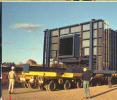
Urządzenie rozładownicze po przybyciu na plac budowy
