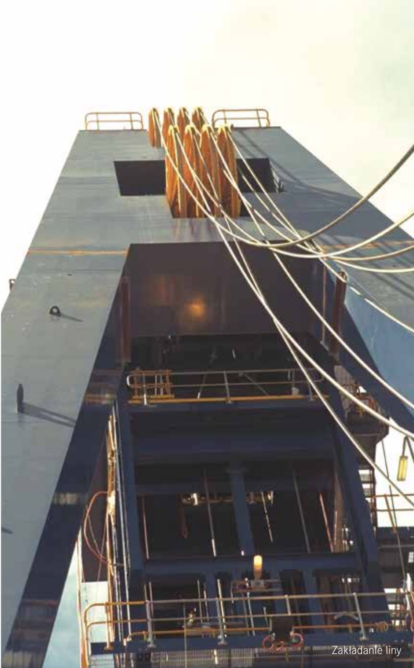
Budowa wieży wyciągowej
